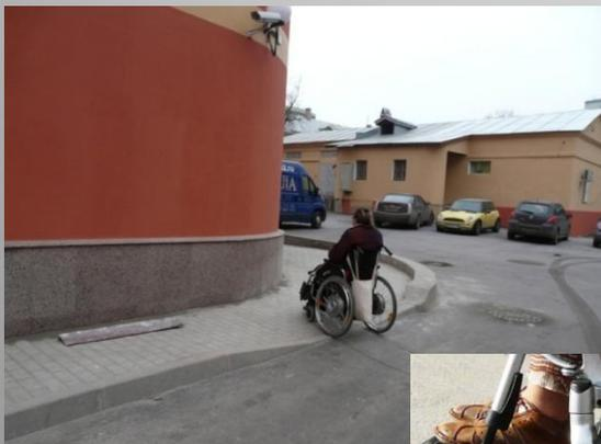
По СП 59.13330 Перепад высот в местах съезда на проезжую часть не должен превышать 0,015 м.
