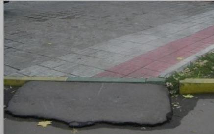
Бордюрные пандусы на пешеходных переходах должны полностью располагаться в пределах зоны, предназначенной для пешеходов, и не должны выступать на проезжую часть. Боковые части должны быть сглажены. На узких тротуарах и в торцах тротуара съезд должен занимать всю ширину тротуара. Понижение бордюрного камня производится путем утапливания в землю, укладка его плашмя недопустима.
