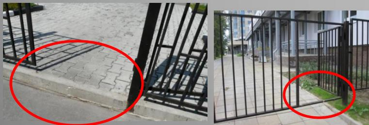
При нарушении указанных требований можно рекомендовать: расширить проход в ограждении, изменить конструкцию калитки, понизить перепад высоты бортового камня при входе на территорию, разместить необходимую информацию об объекте, в том числе знак доступности, если объект доступен
